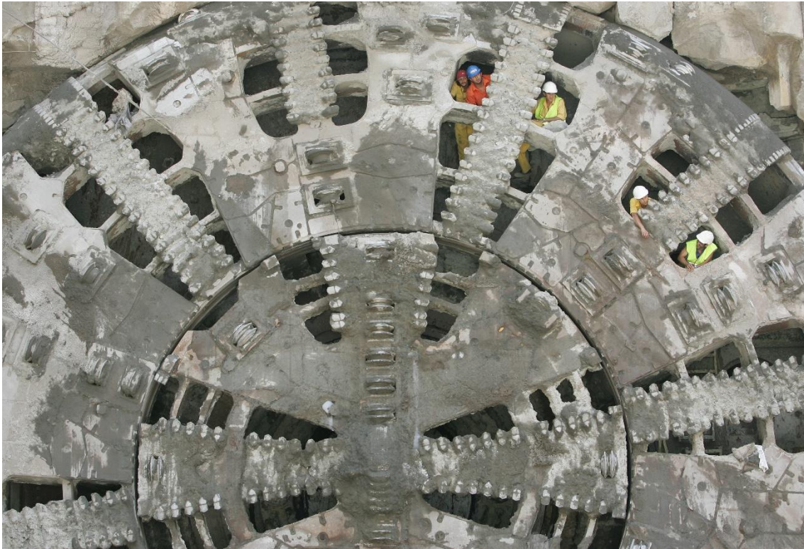
Tuneladora Dulcinea. Imagen fechada el 17 de julio de 2006. Fuente: EFE
