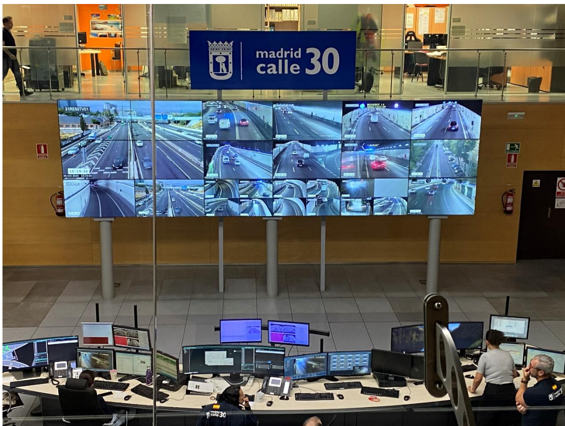
Imagen actual de la 'playa' de pantallas del Centro de Control Madrid Calle 30 Manuel Melis
